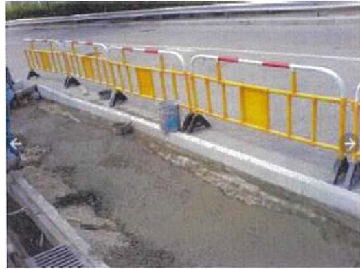
(d) Concrete paving
